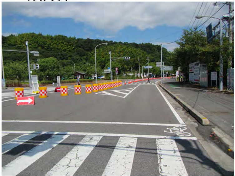
No. 1現場写真
